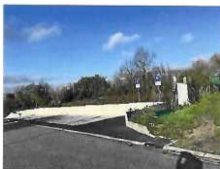
Figure 7 : stationnements récemment créés
