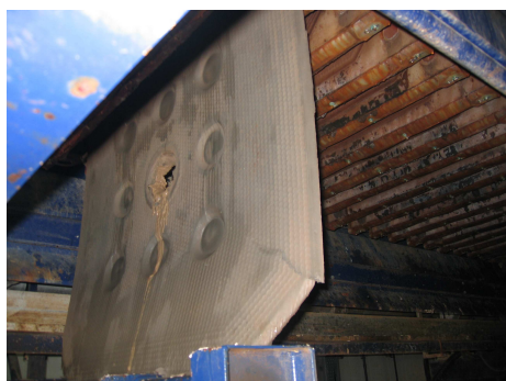
Boue sortant du filtre
